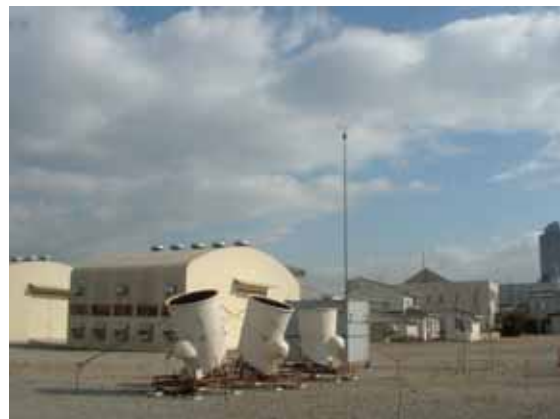
図2 音波レーダ観測状況 (六甲アイランド)
