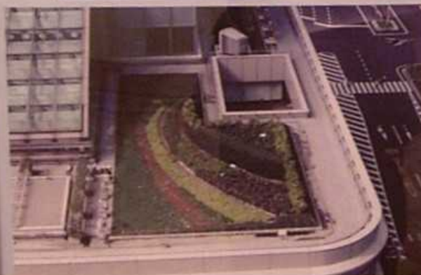
グリーンキューブ (屋上緑化)
