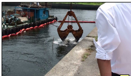
混合材料による藻場マウンド造成
