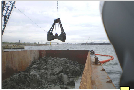
浚渫土砂の採取（川崎港）
