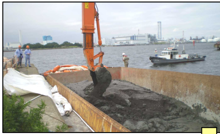
製鋼スラグと浚渫土砂の混合
