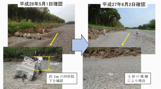
図-9 避難場創出を目的とした水制の設置状況（高時川） 2)
