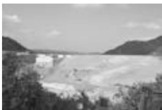
建設中の大分川ダム
