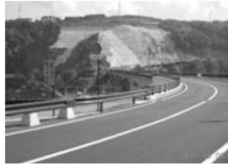
阿蘇に新設された長陽大橋（片谷先生提供）
