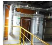
2系統の負圧除じん装置により、作業中は、設備内だけでなく投入室内も常時負圧としている。
