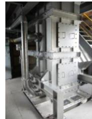
3重のスライドゲート間のホッパからダクトにより除じん装置へ吸引することで、作業中は常に設備内を負圧としている。
