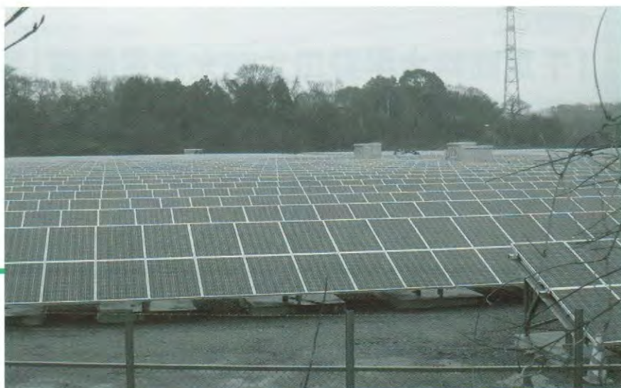
工事中の事業計画地
