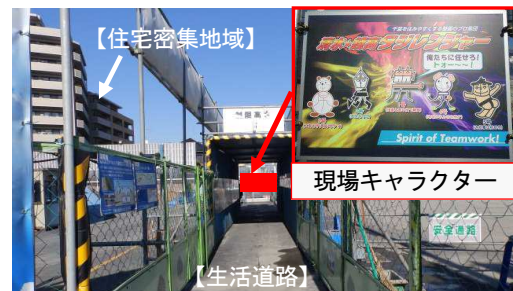
写真-5 生活道路への設置状況
