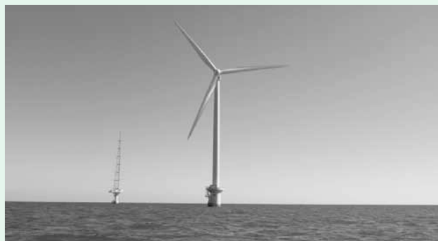
図1 銚子沖に建設された日本で初めての本格的な洋上風力発電所。陸上と異なり、海洋では目視で生物を確認することはとても難しい。そこで考え出されたのが、声を使った新しいアセスメント手法だ。初夏になると、この下でニベの仲間がグーグーと鳴いている。
