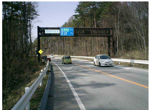
写真 - 2 清里高原有料道路のヤマネブリッジ
