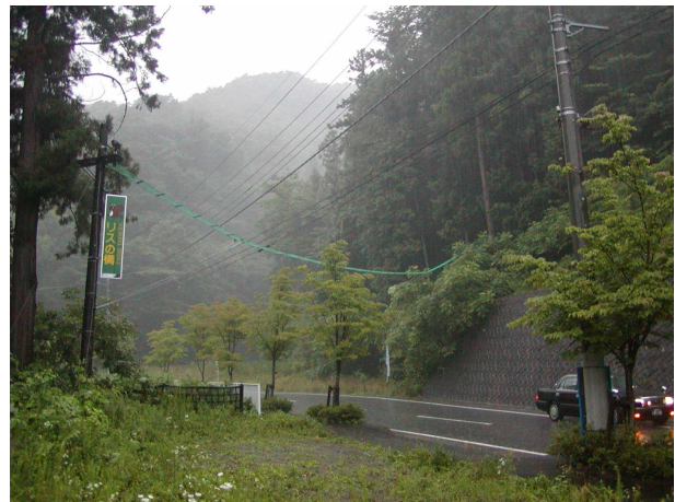
写真 - 3 パストラルびゅう桂台 (山梨県大月市) のニホンリス用の吊り橋
