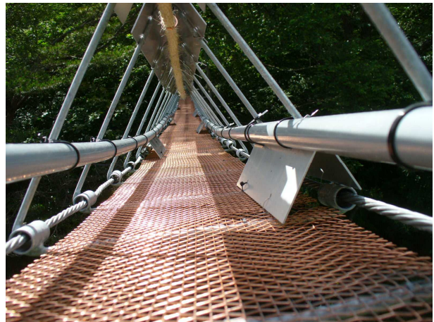
写真 - 5 パスウェイ上部構の様子(右の三角形はヤマネ用のシェルター)
