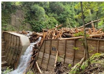
流木捕捉式治山ダムが流木及び土石を捕捉した事例【熊本県球磨村】
