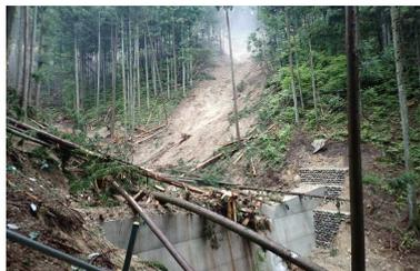
治山ダムが崩壊地から流れ出した土砂や倒木の流出を抑制した事例【岐阜県下呂市】
