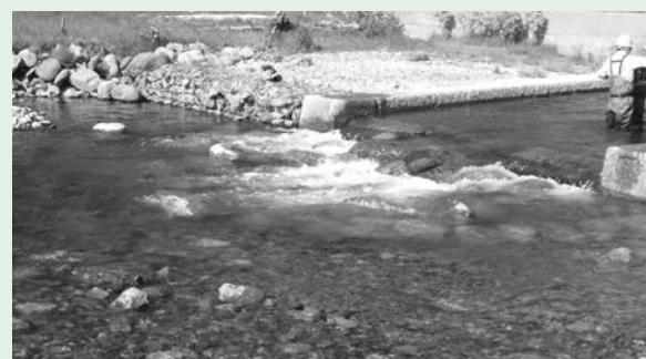
床固工に設置された石組み魚道（北海道；ルシャ川）
