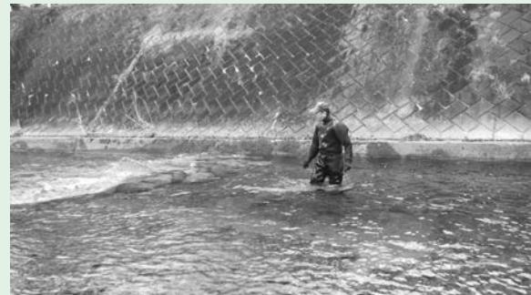
護岸壁に設置された石組み水制工（群馬県；神流川）
