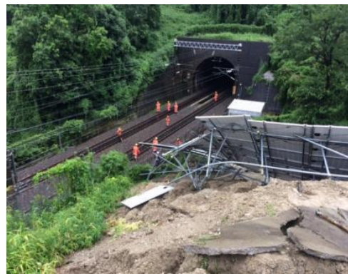
新幹線近くの斜面上部に設置された太陽光発電施設が
