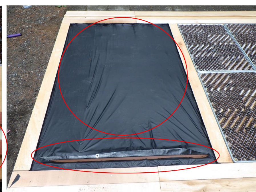
防水シート、雨樋
