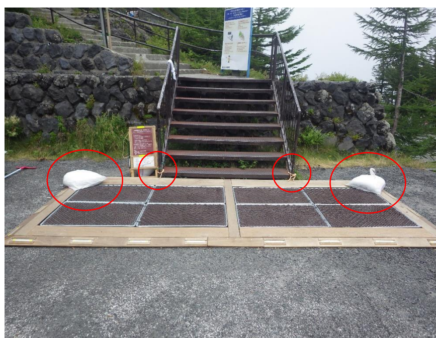
土のう、ロープにより固定
