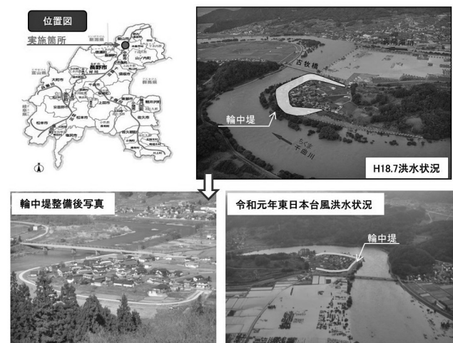
■図－３ 輪中堤の整備事例(千曲川：長野県中野市)
