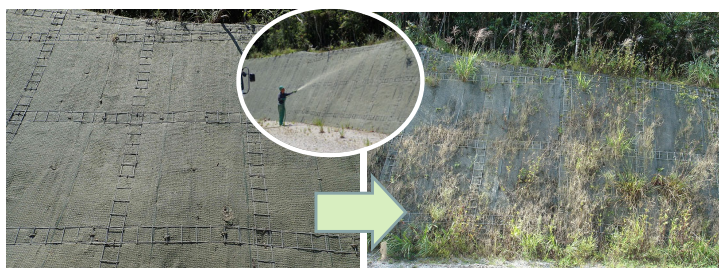
施工から2年経過しても植生侵入のない従来型の自然侵入促進工に対して植生侵入を促した例
