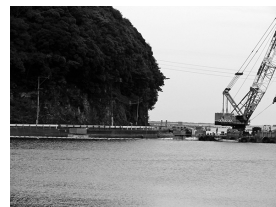
今も改良工事が進む国道388号線
